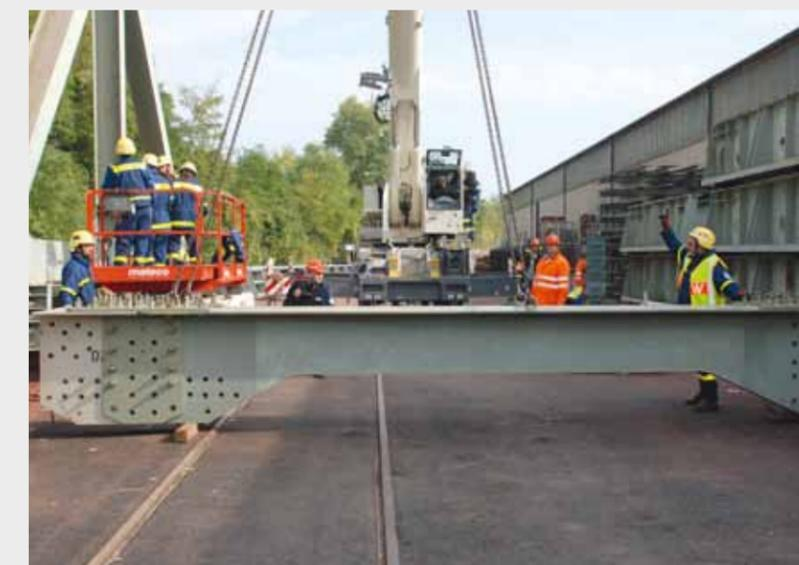
**7,8 Tonnen wogen die schwersten Einzelelemente der in Konz zusammengebauten Eisenbahnbrücken.**
