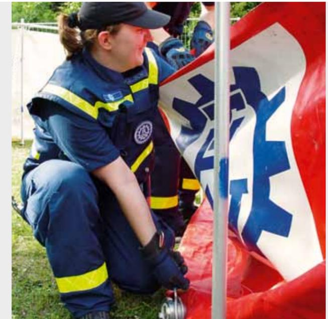
**Das Rohwasser wird in Faltbecken (hier beim Aufbau) für die Aufbereitung chemisch vorbehandelt.**
